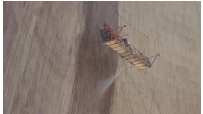
Vornässen der Fläche und Auftragen von KÖSTER NB 1 grau in einem Arbeitsgang.
