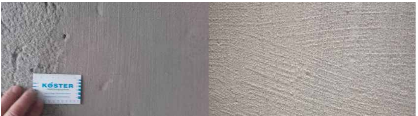
Das Material sollte vertikal und horizontal gebürstet werden, um es in den Untergrund einzuarbeiten.
