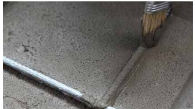
Anwendung von KÖSTER Z1 / Z2 als mineralischem Korrosionsschutz.
