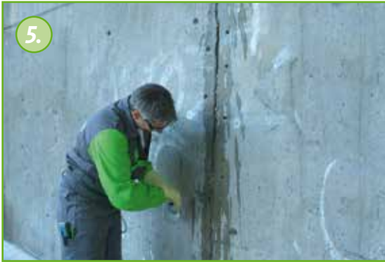
Der Riss wird vorgenässt.
