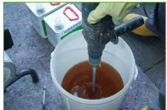
Dazu wird ein langsam laufender elektrischer Mischer mit einem für Harze geeigneten Rührpaddel wie z. B. dem KÖSTER Harzmischer verwendet.
