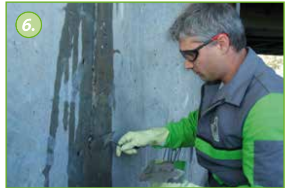
Anschließend kann der Riss z. B. mit KÖSTER KB-Fix 5 geschlossen werden. Das Verschließen des Risses verhindert, dass Injektionsmaterial vorzeitig während der Injektion aus dem Riss herausfließt. Die Verarbeitungszeit beträgt circa 5 Minuten, abhängig von der Umgebungstemperatur und der Luftfeuchtigkeit.
